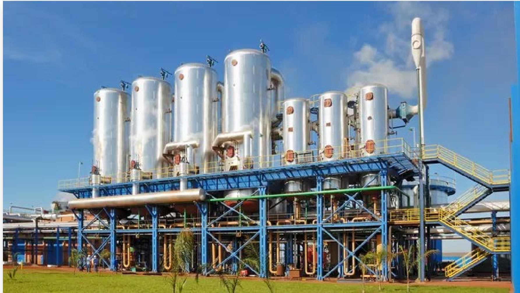
Tratamento de caldo na usina Ouroeste, da Bunge
